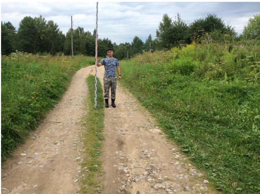
Рис. 7. Объект «Уличные газопроводы дер. Дзержинка Юхновского района» Калужской области. Видовая точка 2. Вид с юга.
