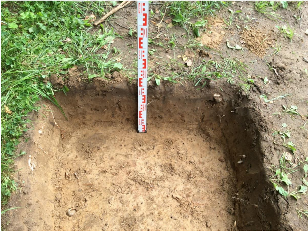
Рис. 18. Объект «Уличные газопроводы дер. Держинка Юхновского района» Калужской области. Шурф 1. Вид с севера.
