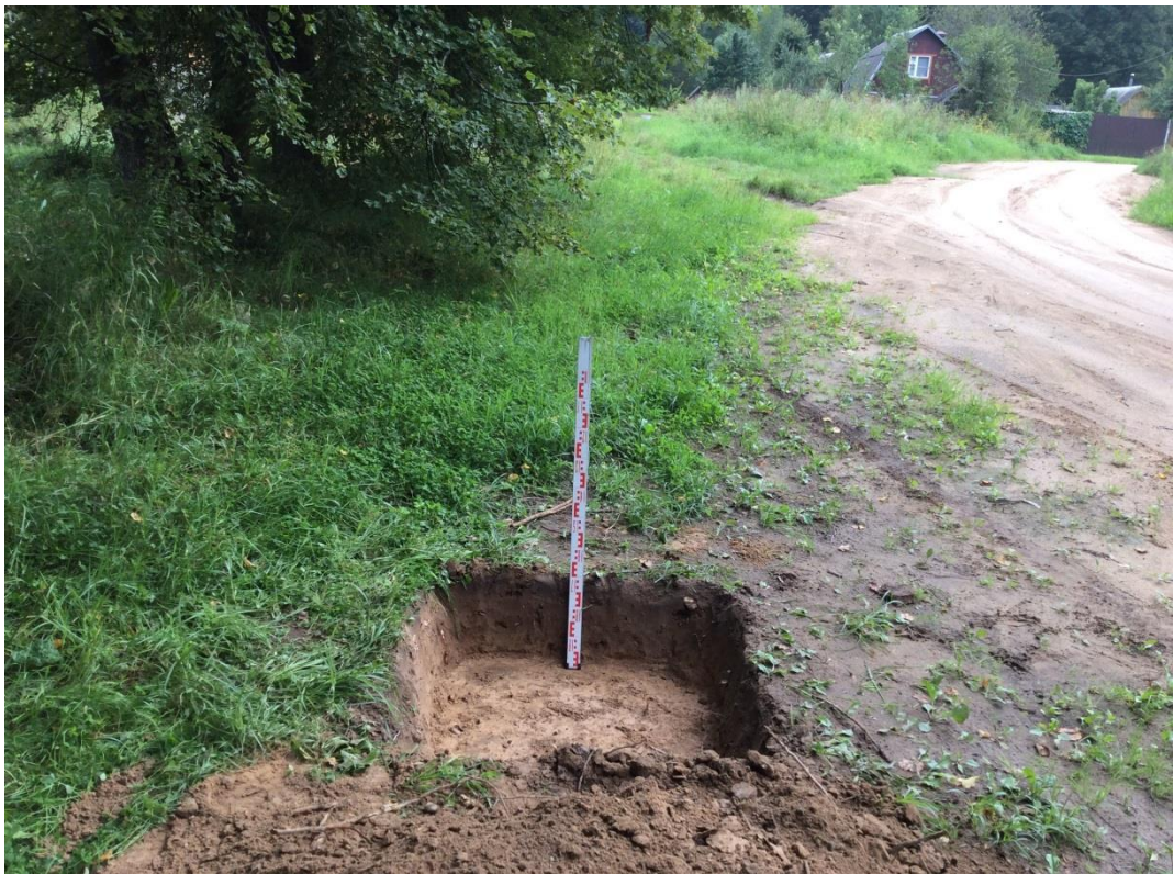
Рис. 17. Объект «Уличные газопроводы дер. Держинка Юхновского района» Калужской области. Шурф 1. Вид с севера.
