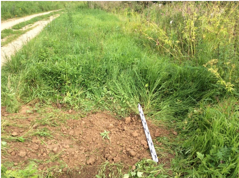
Рис. 25. Объект «Уличные газопроводы дер. Держинка Юхновского района» Калужской области. Засыпанный шурф 2. Вид с запада.
