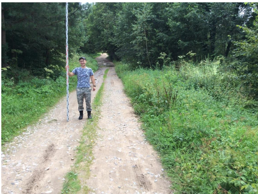
Рис. 8. Объект «Уличные газопроводы дер. Держинка Юхновского района» Калужской области. Видовая точка 3. Вид с севера.
