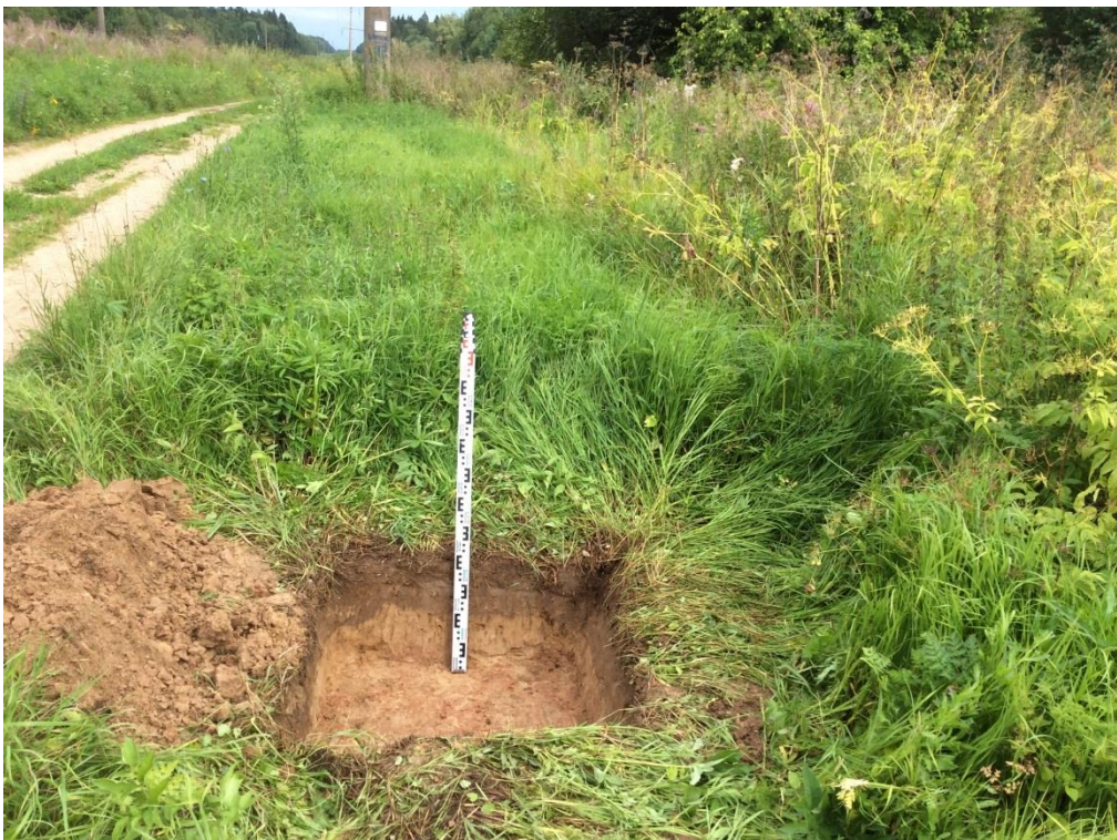
Рис. 23. Объект «Уличные газопроводы дер. Держинка Юхновского района» Калужской области. Шурф 2. Вид с запада.
