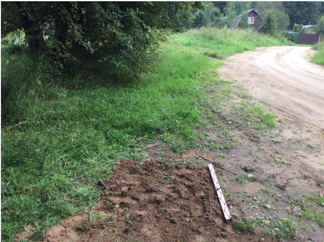
Рис. 19. Объект «Уличные газопроводы дер. Держинка Юхновского района» Калужской области. Засыпанный шурф 1. Вид с севера.
