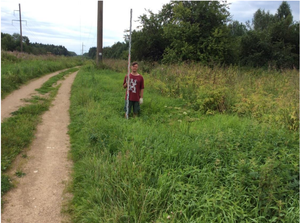
Рис. 20. Объект «Уличные газопроводы дер. Держинка Юхновского района» Калужской области. Место шурфа 2. Вид с запада.
