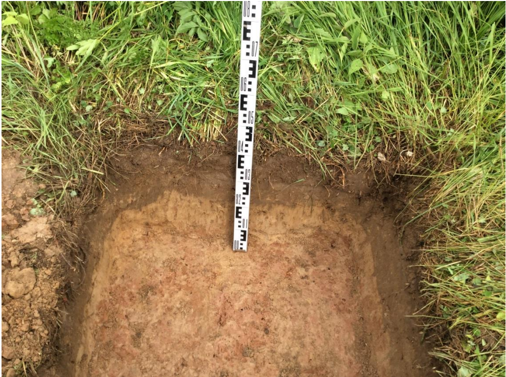
Рис. 24. Объект «Уличные газопроводы дер. Держинка Юхновского района» Калужской области. Шурф 2. Вид с запада.
